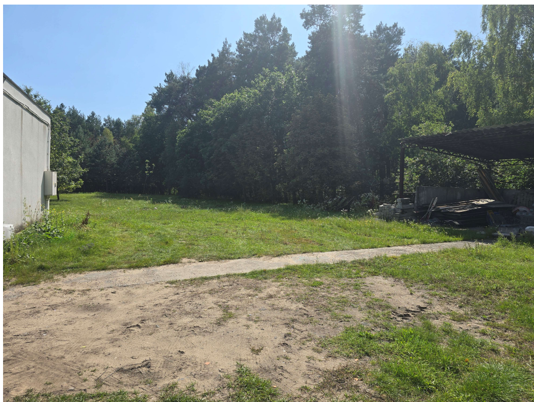
Zdjęcie nr 6 stan istniejący – chodnik do rozbiórki
